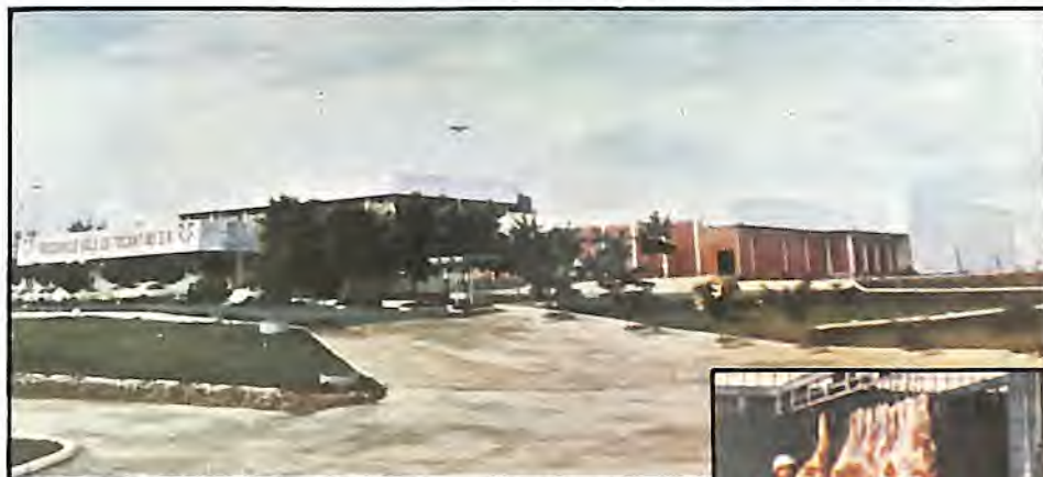
FRIGORÍFICO VALE DO TOCANTINS S/A Imperatriz - MA
